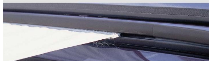
Sonnensegelbefestigung mit Einzugkeder
